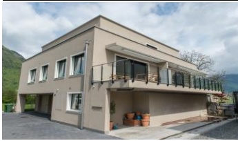
Wohnhaus Rotzring Stansstad
